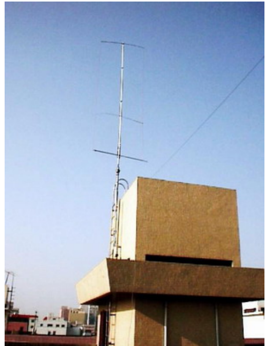
תמונה 1: ההנטנה ל HF עם קוטביות אופקית של Robert Suen BV3FG מורכבת על עמוד PVC ומסתובבת בעזרת מנוע
